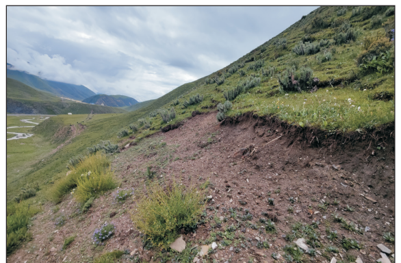
b 坡脚塌陷
